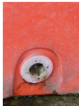
รูปที่ 1. ถังที่มีรูระบายน้ำด้านข้างซึ่งอยู่สูงจากพื้นเล็กน้อยและเสี่ยงต่อการปนเปื้อน
